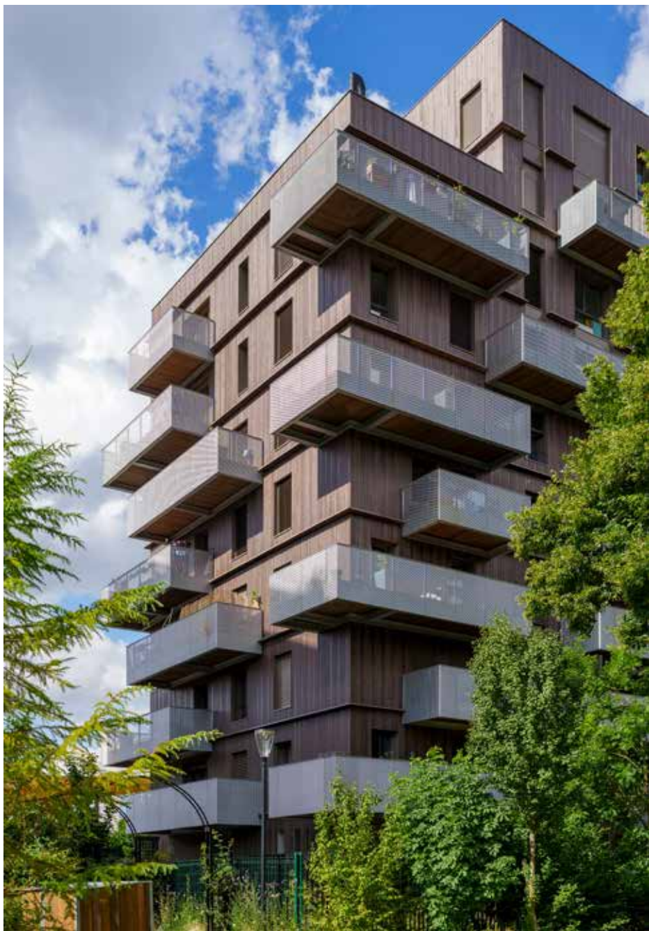
Le lot 6 : 9 - 11 rue Paul Bourget, est un immeuble en structure bois 38 logements intermédiaires (label Bâtiment Bas Carbone - BBCA)
