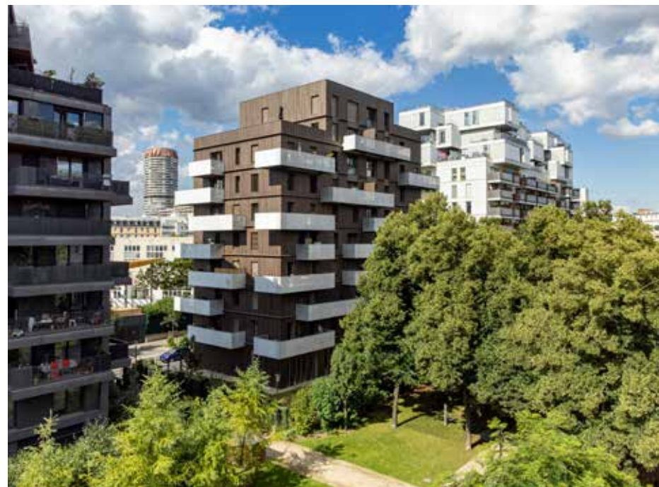
Propriétaire Elogie-Siemp - Architectes Philippon Kalt Livraison octobre 2023
