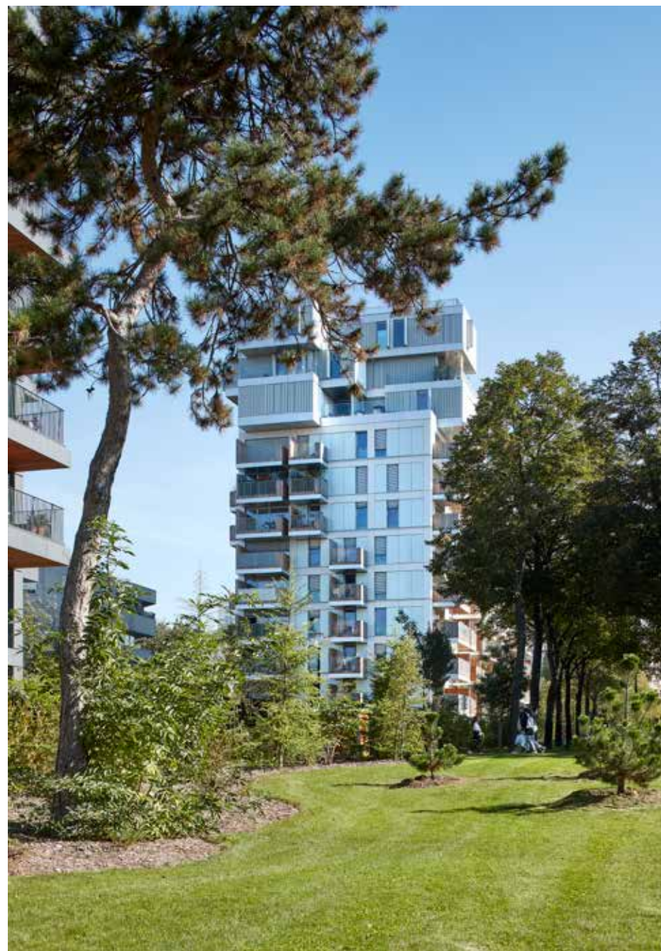
Propriétaire Elogie-Siemp - Architectes Naud et Poux Livraison 2019
