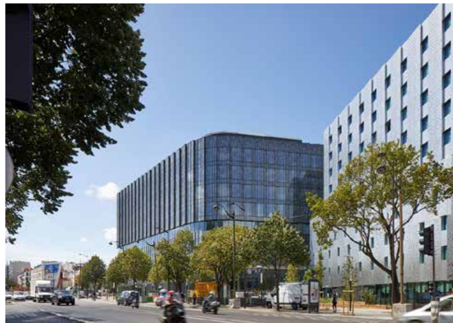
Le lot 13 - 14 : îlot économique, 12 - 20 avenue de la Porte d'Italie , bureaux, salle d'escalade, hôtel. Propriétaire Vinci - Architecte X'TU Livraison 2019
