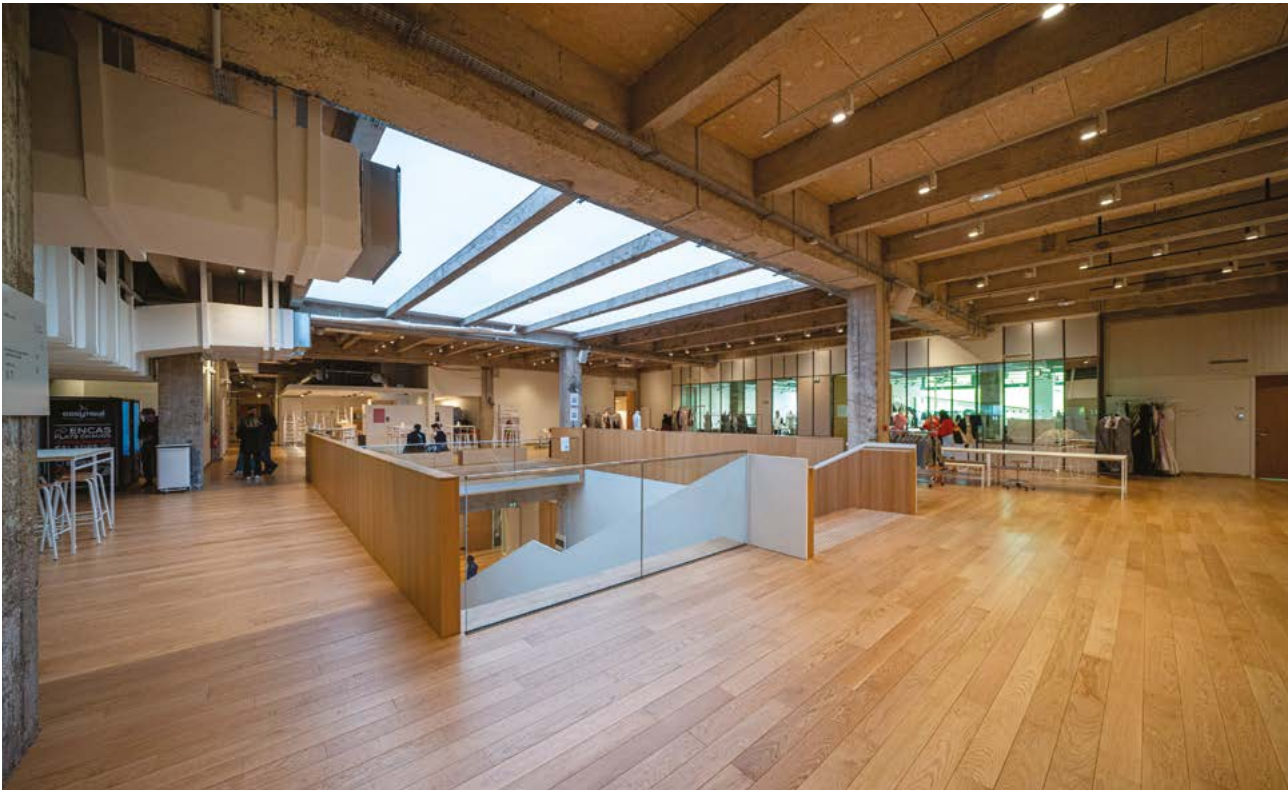
● Les puits de lumière ont été créés au niveau de la toiture.
