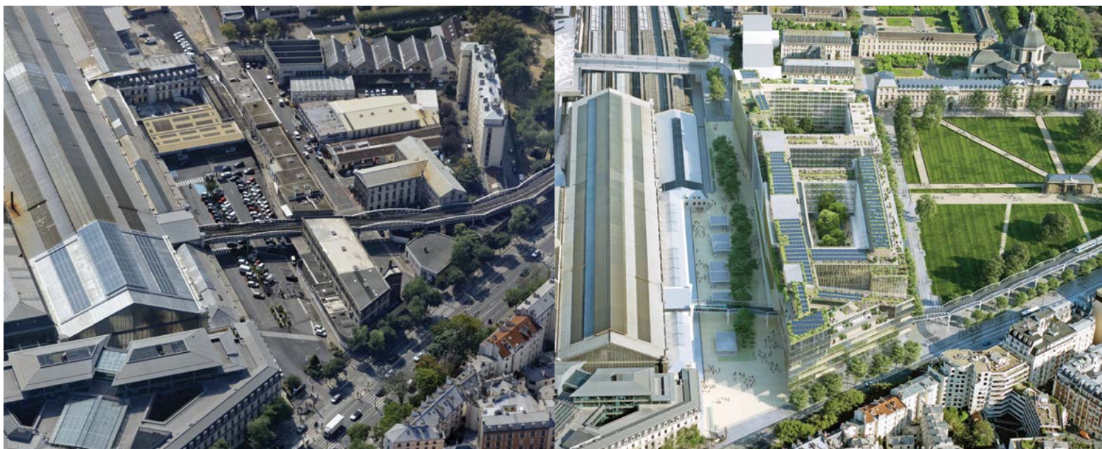
● Vue générale du secteur Austerlitz.
