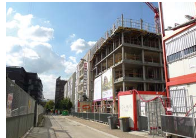
Vue du chantier du lot 9 depuis la rue Gerda Taro.
