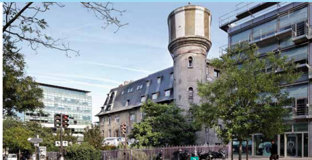
7 LES FRIGOS - ARTISTS' STUDIOS Construction: 1921 (Compagnie Ferroviaire de Paris-Orléans)
