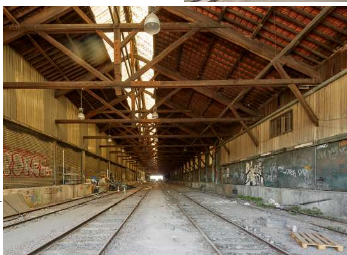
La charpente de la Rapée supérieure
