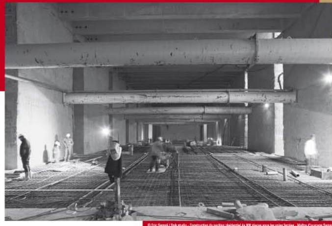
© Eric Séguy / Jpb studio - Construction du parking résidentiel de 800 places sous les voies ferrées - Maître d'ouvrage Semapa
